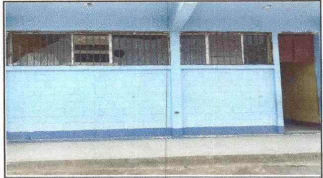
Foto 2: Sustitucion de vidrios
