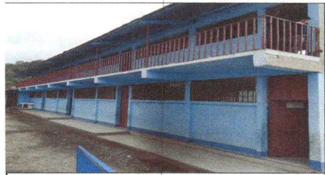
Foto 6: Pintura en muros exteriores
